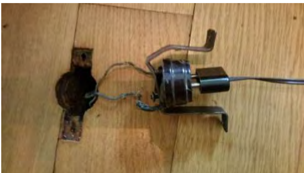
Bild 9: Mini-Steckdose im Fußboden für mobile Dienstbotenklingel
